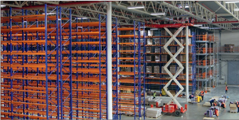
Рис. 2. Многоуровневые стеллажи, высотные работы. Установка оборудования на перекрытиях крыши склада
